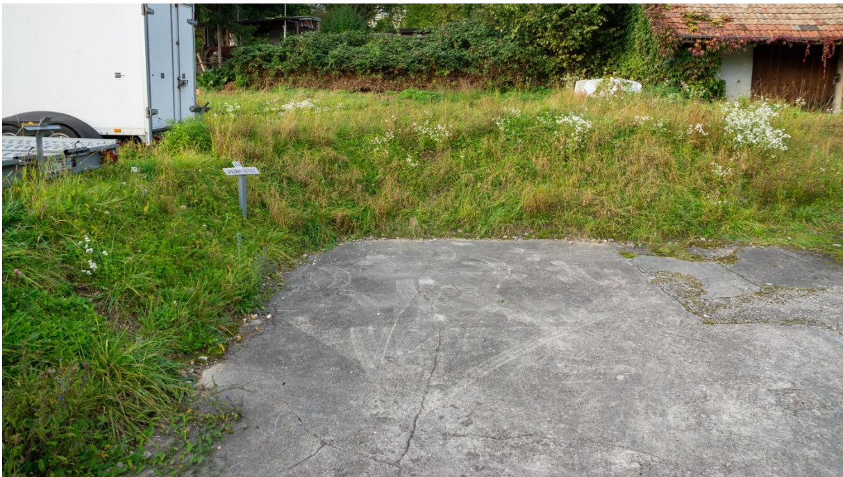
Abbildung 42: Betonplatte auf dem östlichen Teil des Parkplatzes an der Talstrasse, entlang derer viele Erdnesteingänge von T. magnum zu finden waren und besonders große Nestanlagen am nördlich gelegenen Hang (Aufnahme vom 08.10.2025)
