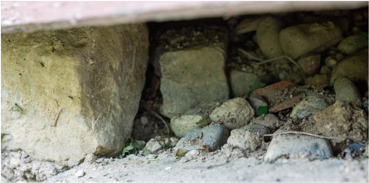
Abbildung 14: Gartenhütte am westlichen Rand des Gemeinschaftsgartens, unter der im sandig-kiesigen Untergrund T. magnum Nesteingänge angelegt hatte. (Aufnahme vom 08.10.2025)
