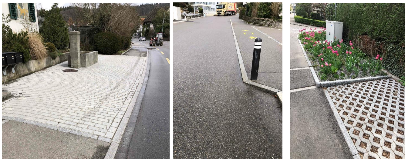
Beispiel «Granitpflasterung» beim Brunnen in Weinigen, Beispiel «Poller» welche die Verengung der Strasse signalisiert, Beispiel Parkplatzfläche mit Rasengittersteinen
